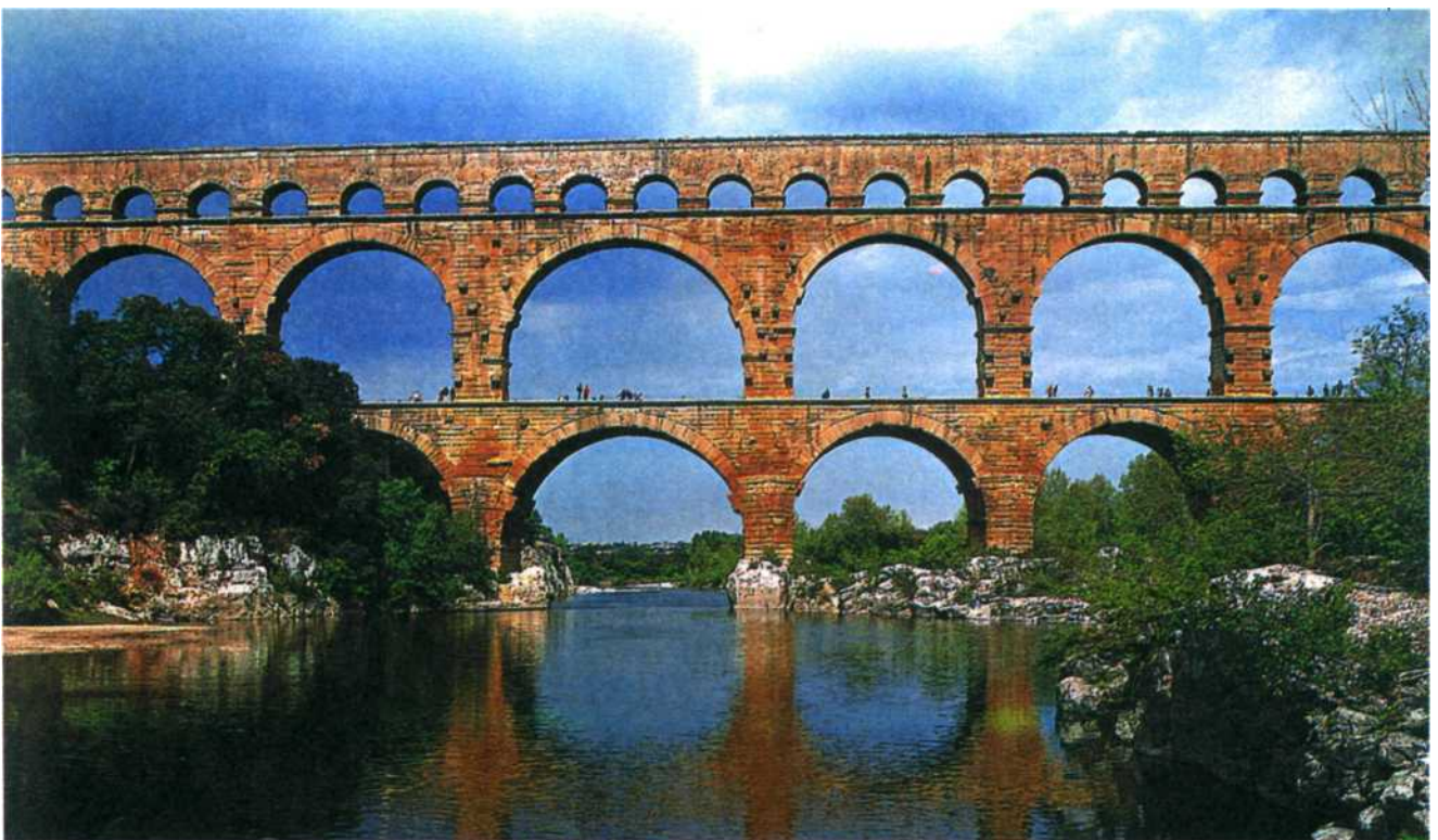
Гарский мост (римский акведук для водоснабжения в Ниме). Франция. I в. до н. э.
